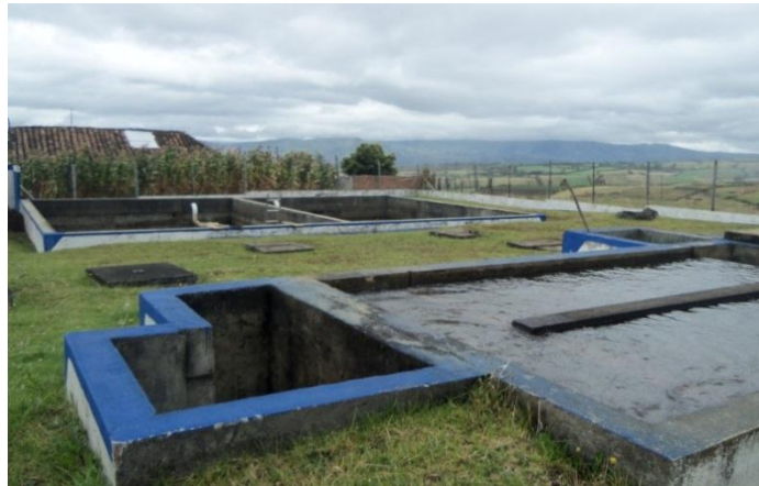
Fotografía 12. Planta de tratamiento de agua potable tipo FIME acueducto urbano municipio de Yacuanquer
