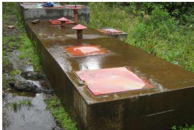
Fotografía 11. Tanque desarenador acueducto la Magdalena
