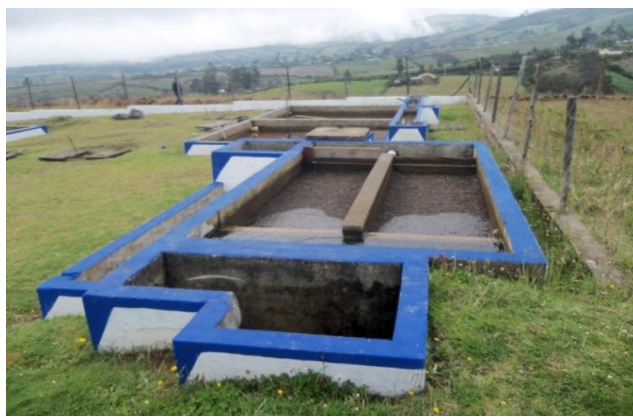
Fotografía 14 . Unidad de filtración rápida.
