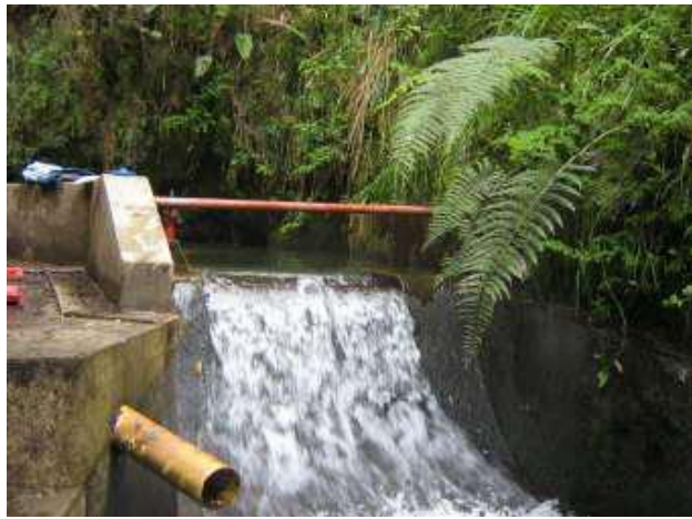
Fotografía 8. Lámina de agua bocatoma acueducto la Magdalena
