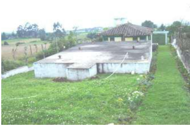
Fotografía 17. Losa superior tanque de almacenamiento acueducto urbano
