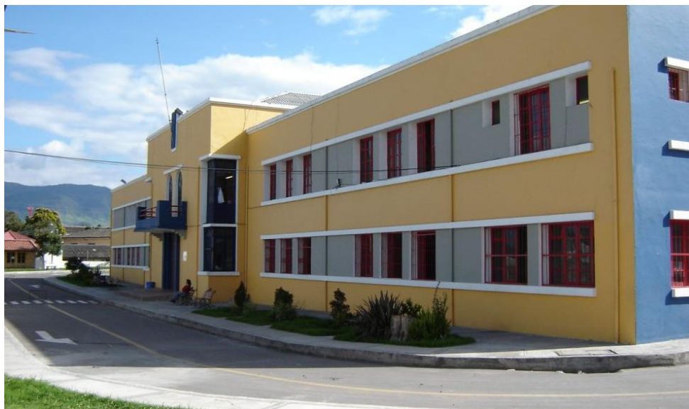
Imagen 1. Fachada Institución Educativa Municipal Técnico Industrial
