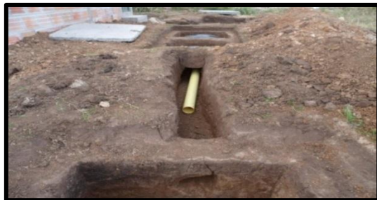
Imagen 22. Excavación e instalación tubería sanitaria
