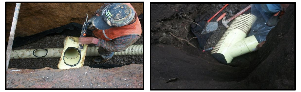
Imagen 76. Instalación Sillas YEE
