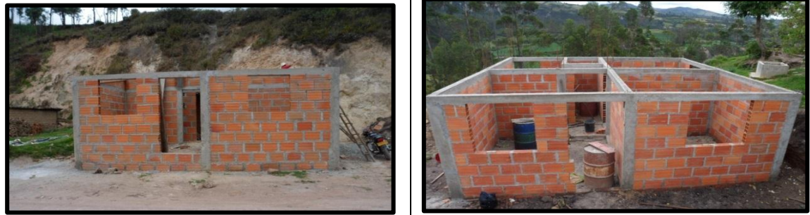
Imagen 13. Columnas y vigas
