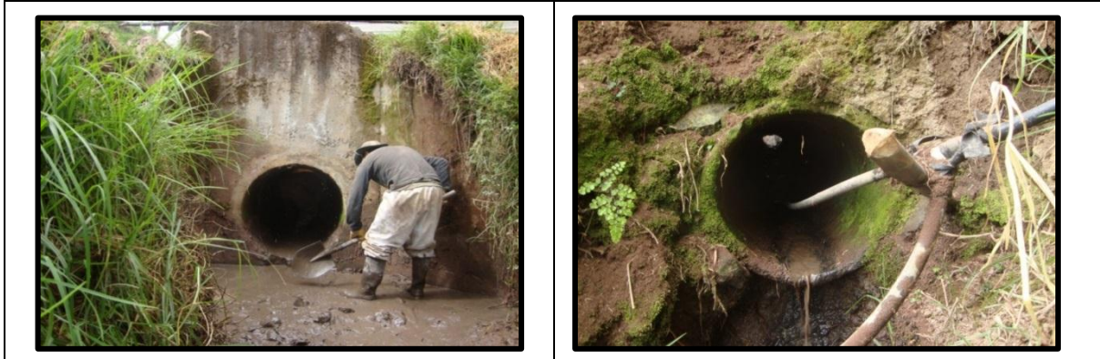
Imagen 42. Limpieza de tubería.
