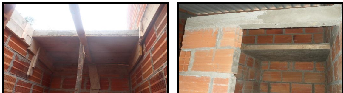
Imagen 15. Placa de soporte tanque
