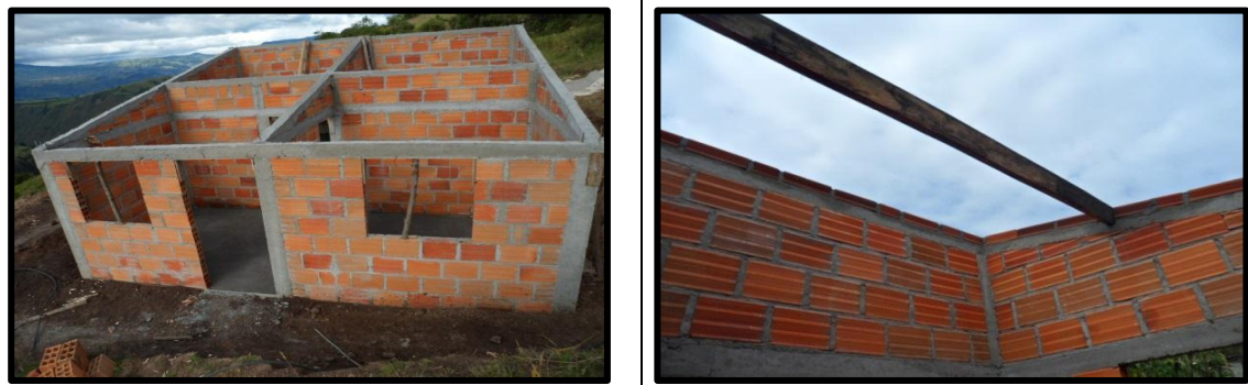
Imagen 14. Viga de coronación
