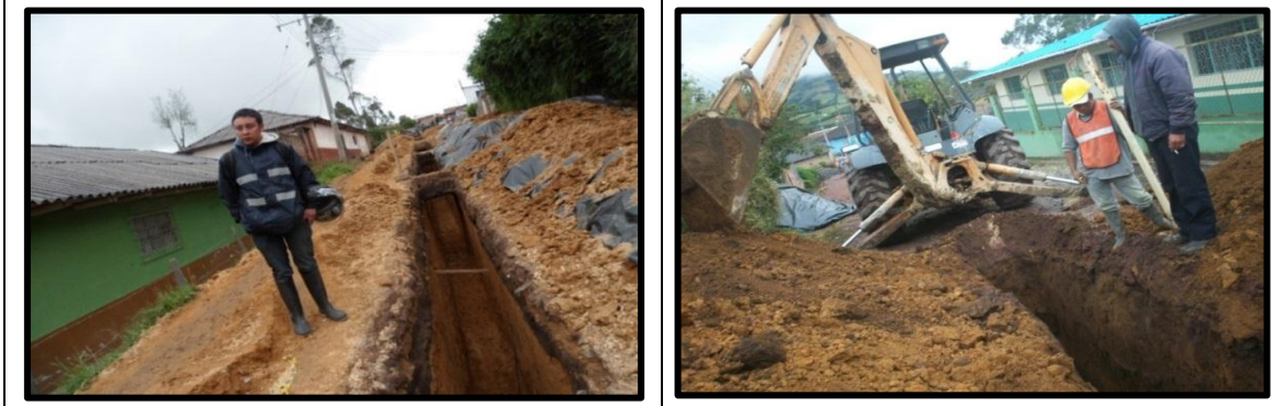
Imagen No. 73 Excavación a máquina
