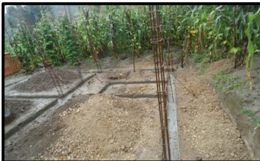
Imagen 07. armado de acero de refuerzo para columnas
