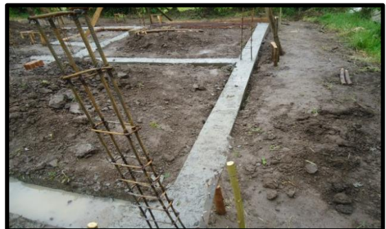
Imagen 08. fundición de columnas
