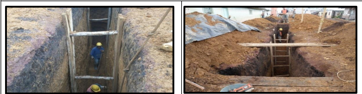
Imagen 74. Excavaciones con entibados
