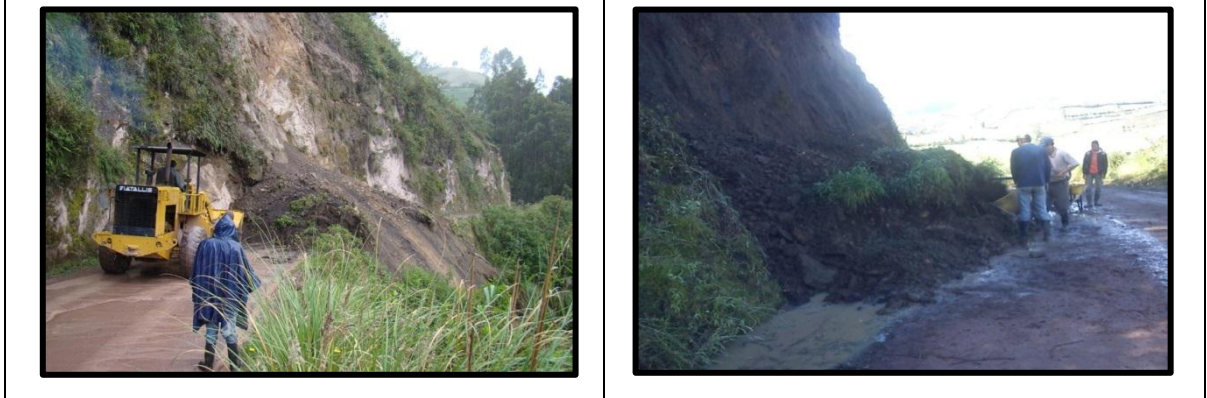
Imagen 41. Remoción de derrumbes
