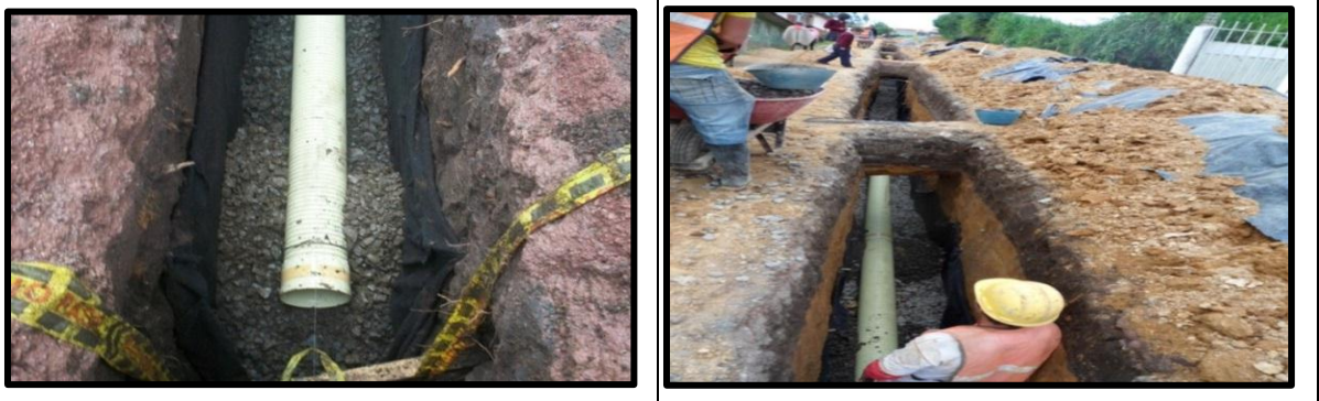
Imagen 75. Instalación de Tubería D=8"
