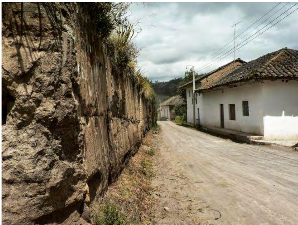
Figura 4. Muros de tapia en la Vereda San Pedro, Municipio de Potosí. 25
