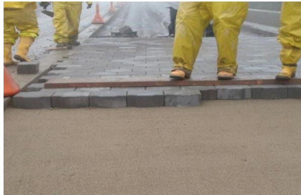
Figura 2.11. Arena para soporte del adoquín.
