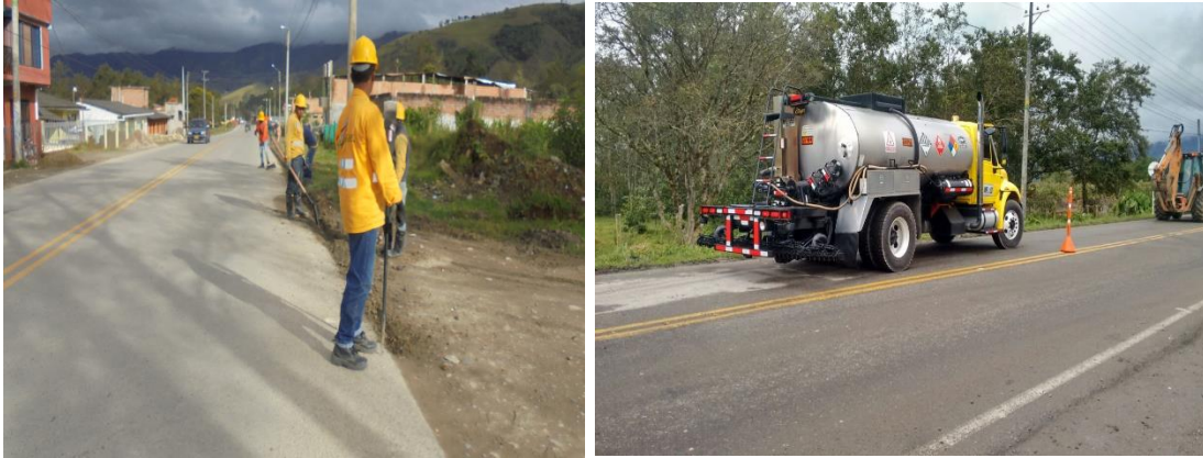
Figura 2.26. Estado inicial de la obra.
