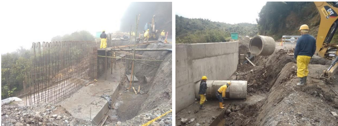
Figura 2.19. Ampliación de alcantarilla y construcción muro de contención.
