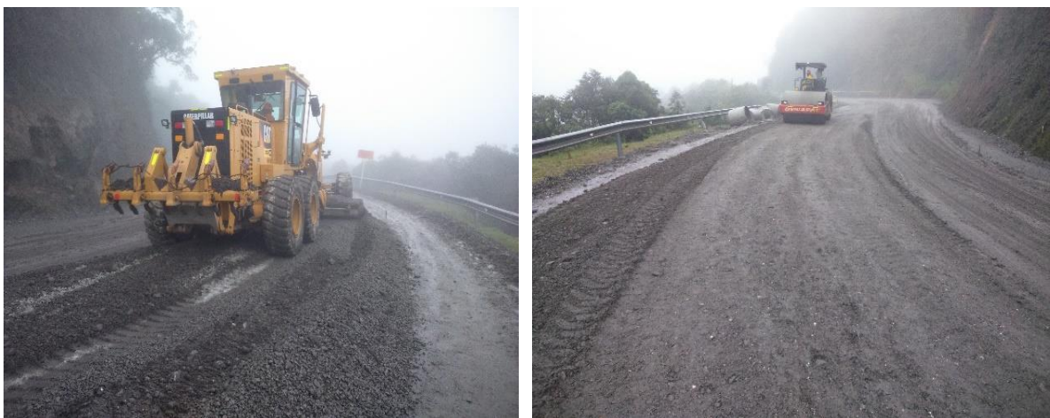
Figura 3.2. Mezcla de base y cemento y compactación base estabilizada.
