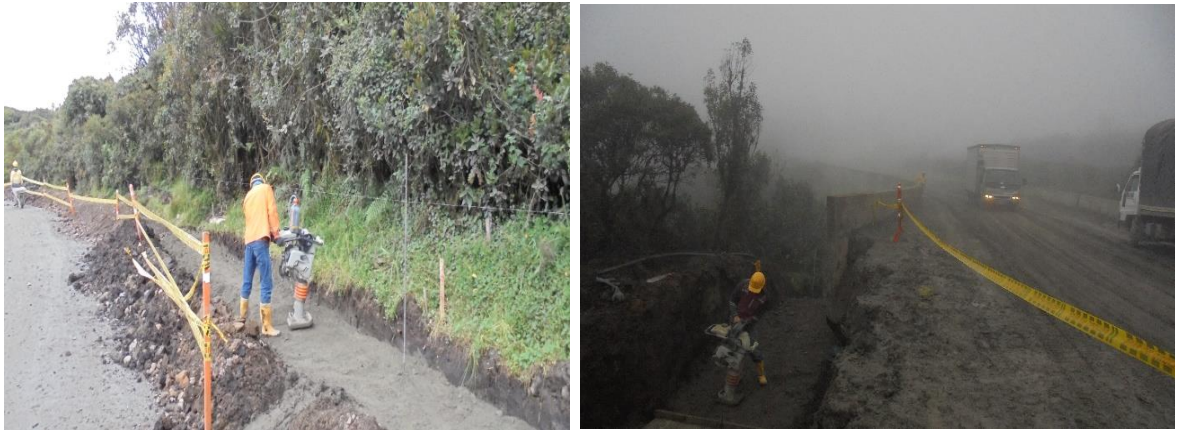
Figura 3.5. Compactación en los mejoramientos.
