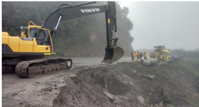
Figura 2.15. Demolición y ampliación de alcantarilla.
