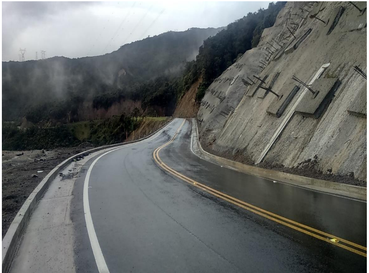
Figura 2.2. Estado final de la obra
