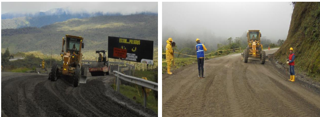
Figura 2.23. Conformación de la base granular.
