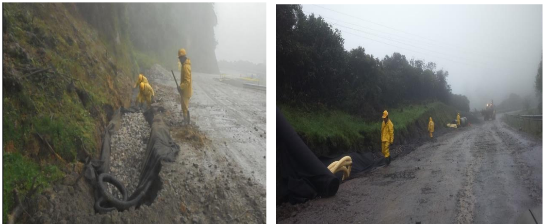
Figura 2.22. Construcción de drenes longitudinales.
