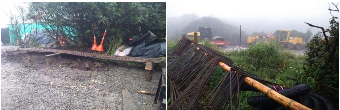
Figura 3.6. Acopio del acero en obra.
