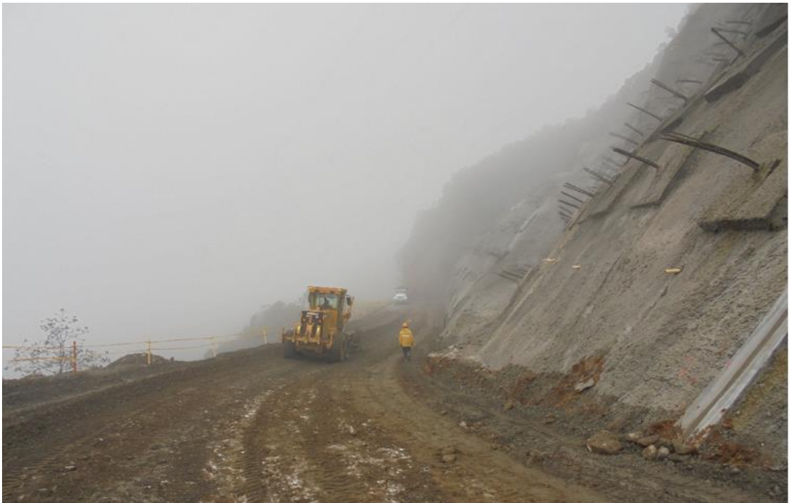
Figura 2.1. Estado inicial de la obra.
