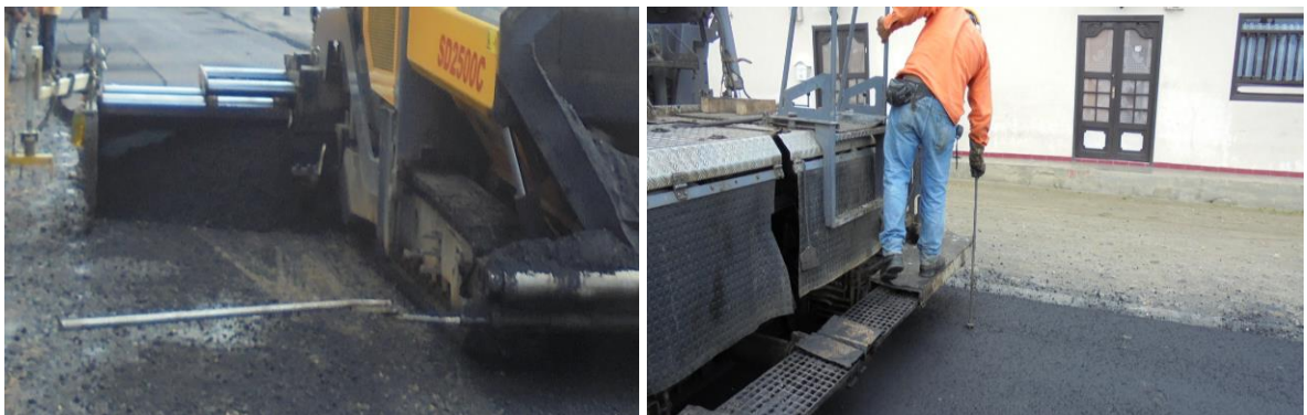
Figura 3.7. Control de espesores de la mezcla asfáltica.
