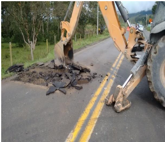
Figura 2.27. Corrección de fallos en el pavimento existente.
