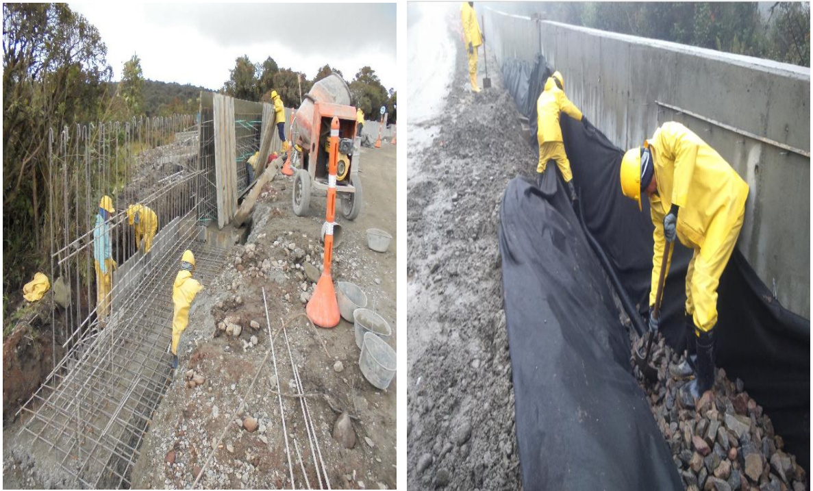
Figura 2.7. Muro cimentación superficial.
