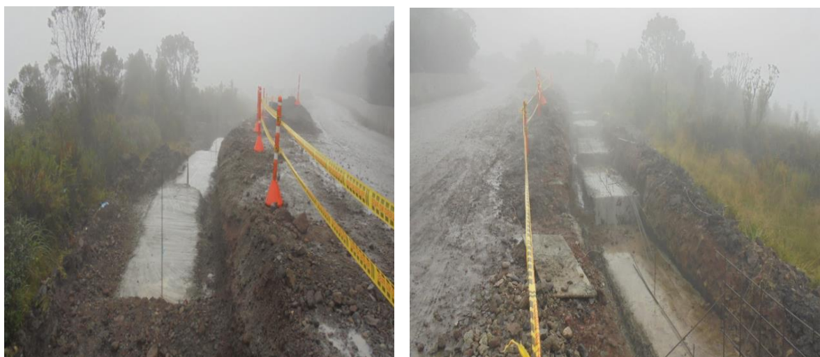
Figura 3.3. Excavación mejoramiento y solados.
