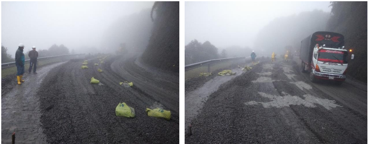
Figura 3.1. Suministro de cemento para base estabilizada.
