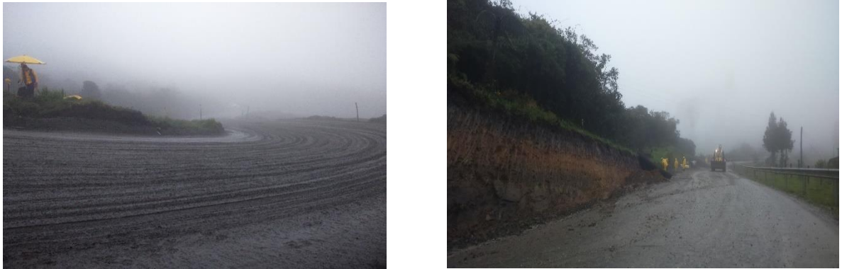
Figura 2.14. Estado inicial de la obra.
