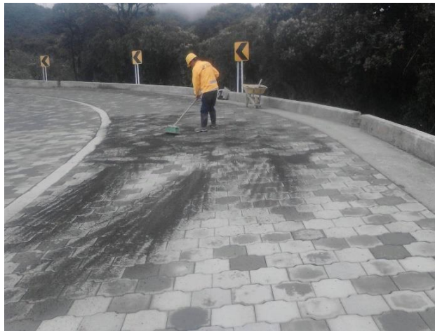
Figura 2.13. Arena de sello para juntas entre adoquín.
