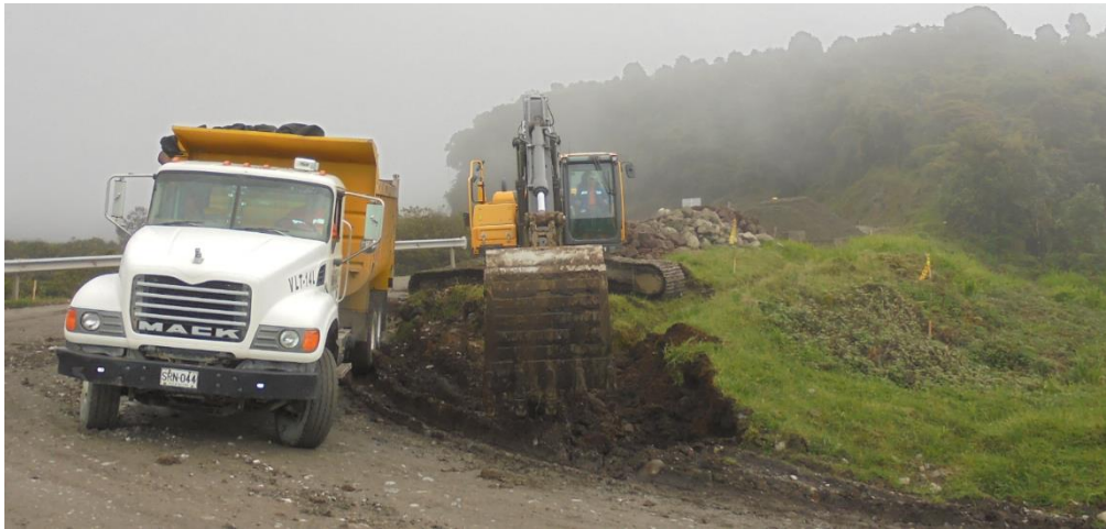
Figura 2.16. Ampliación de la vía.
