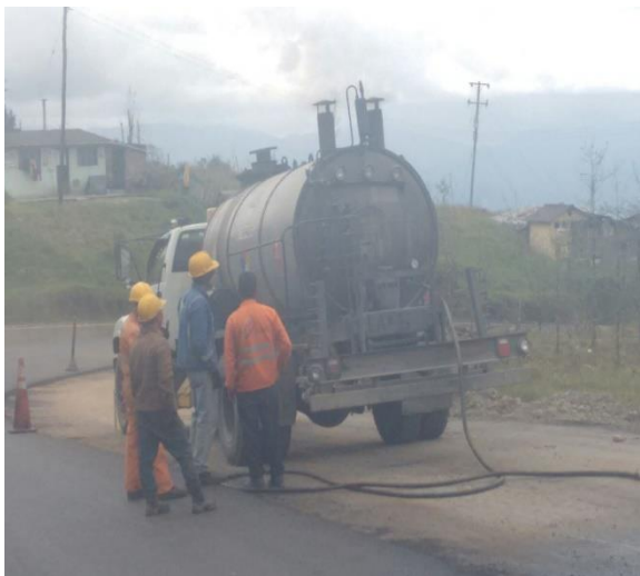
Figura 2.25. Riego de imprimación y colocación mezcla asfáltica MDC2.
