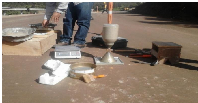
Figura 2.24. Toma de densidades a la base granular.
