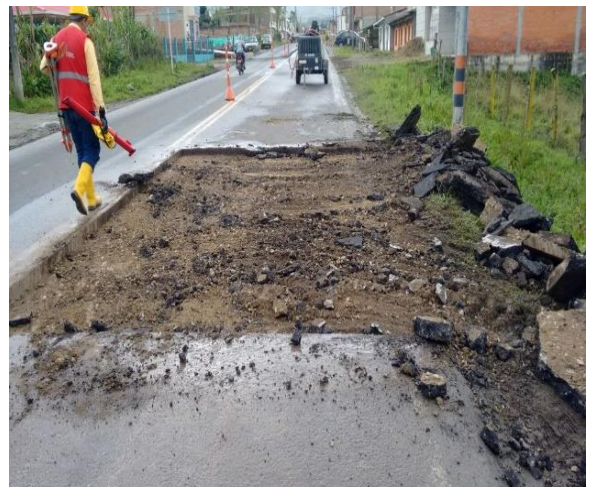
Figura 2.27. Corrección de fallos en el pavimento existente.
