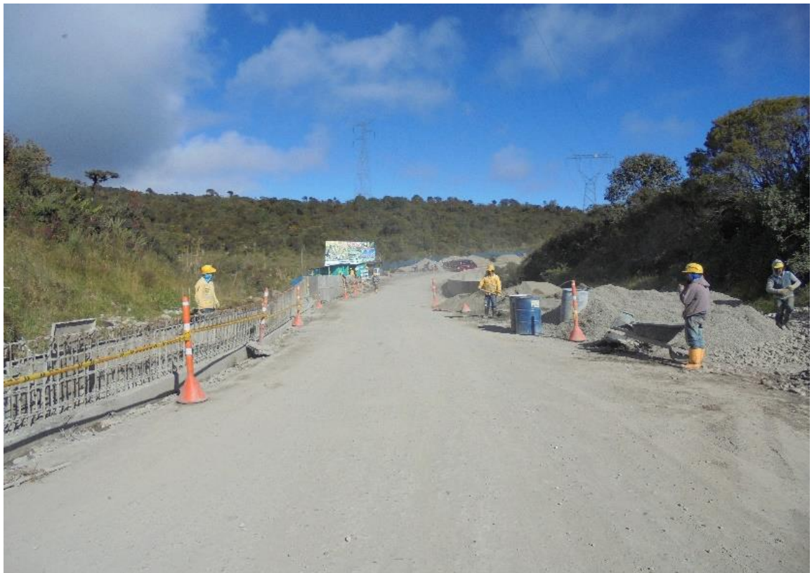
Figura 2.3 Estado inicial de la obra.
