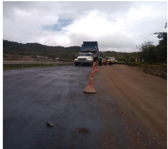
Figura 2.25. Riego de imprimación y colocación mezcla asfáltica MDC2.
